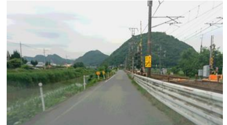
(狭隘な県道344号長谷地区)
